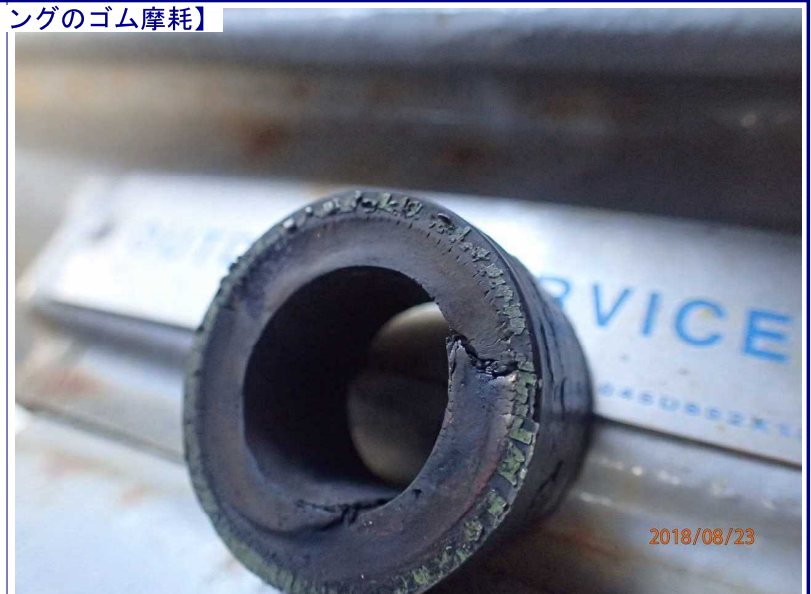
【固定ボルトの摩耗】
